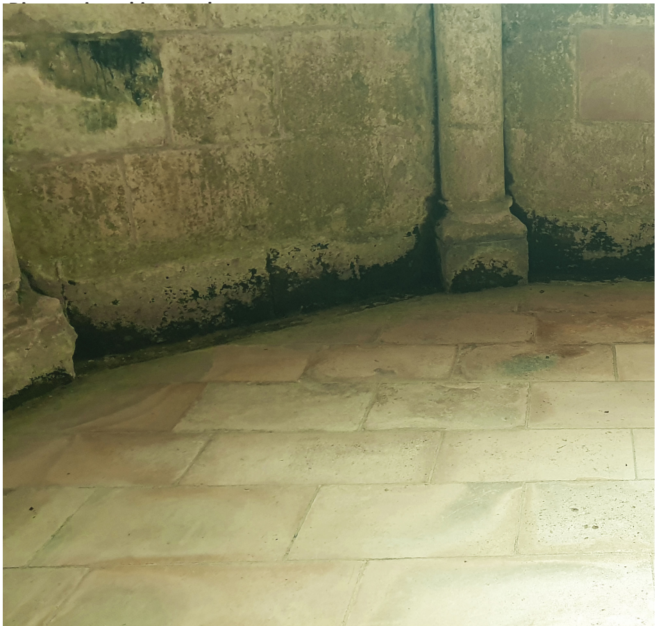
Traces d'humidité dans l'abside
