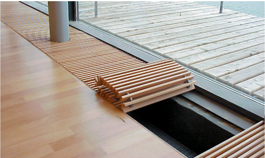
Exemple de faux plancher technique
