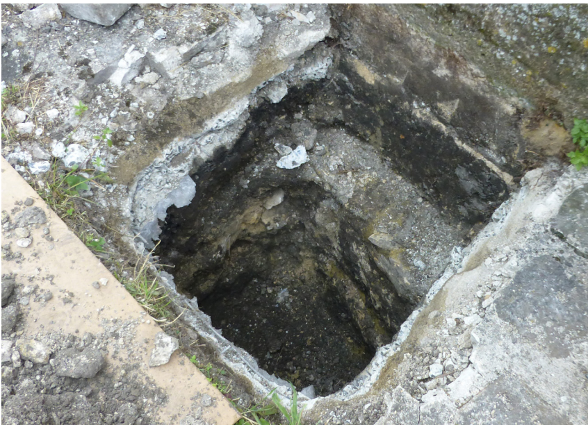
Réalisation de sondage au droit des murs
